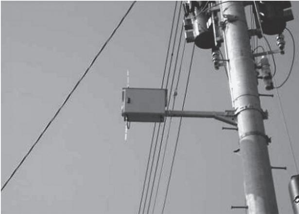
写真-3 電柱上に設置された通信ノード
