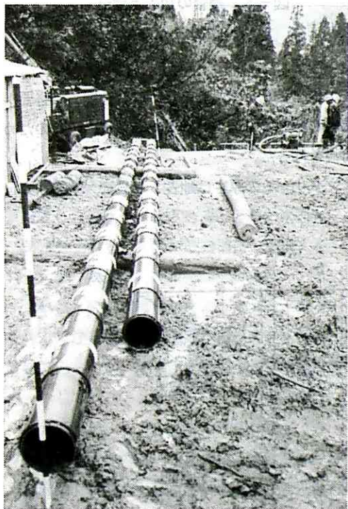
写真-7 建込用鋼管杭（節付）
