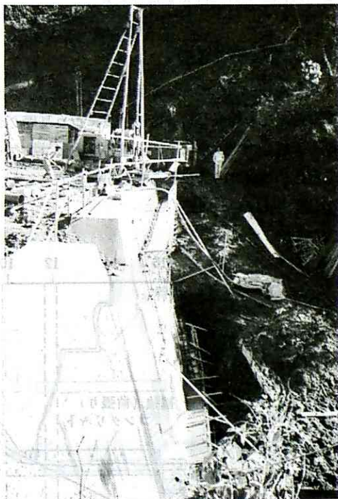
写真-8 鋼管杭の建込作業
