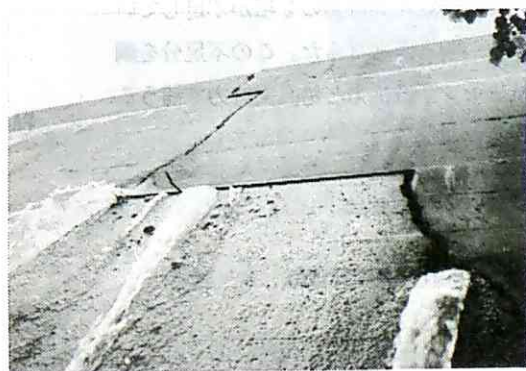
写真-6 亀裂からの漏水
