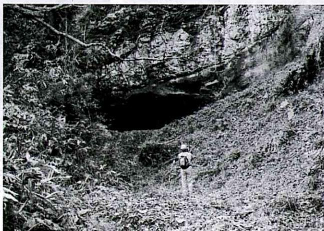
写真-11 坑口の崩落土砂
